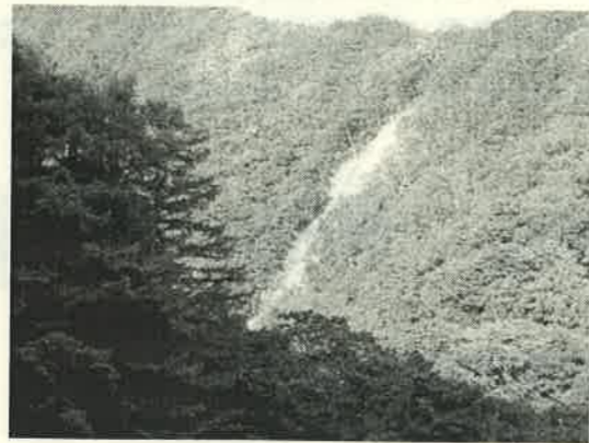
(蟹岡トンネル入り口付近から撮影した崩落現場)
