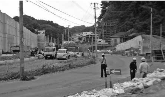
前須賀日立浜線道路改良工事の様子
