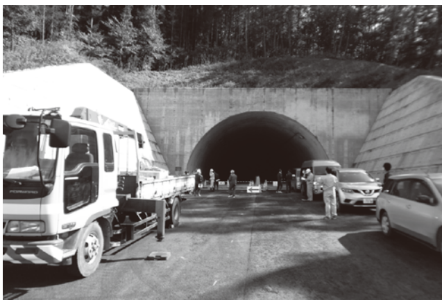
早期完成が望まれる新区界トンネル
