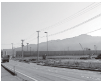
藤原ふ頭工業用地の空き地
