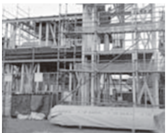
復興事業の工事現場
