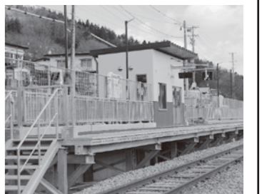
新設された八木沢・宮古短大駅
