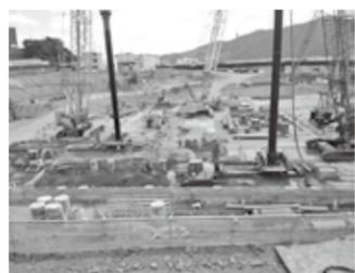
仮締切りで基礎工事中の閉伊川水門整備工事
