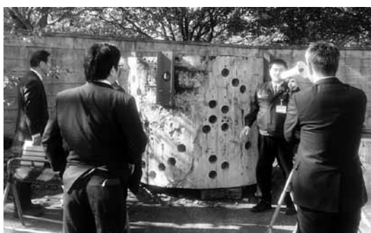
橋脚の腐食についての説明
