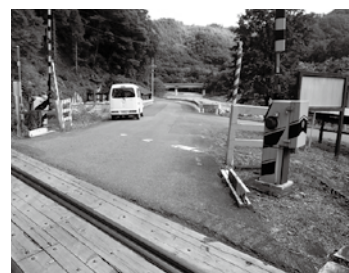
冠水対策が必要な市道
