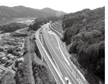
宮古南 IC から山田方面へ延びる道路
