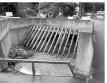
スリットダム
