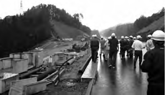
山田宮古道路の工事現場
