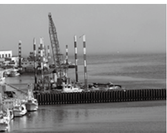
水門工事中の閉伊川河口
