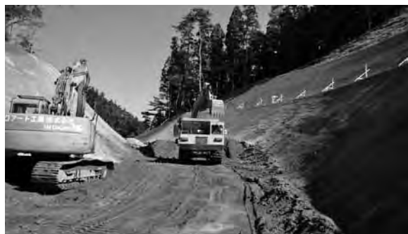
河南高浜線の工事の様子
