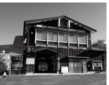
浸水被害から復旧した34分団屯所（墓目）
