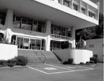
複合施設として再配置が検討されている田老総合事務所
