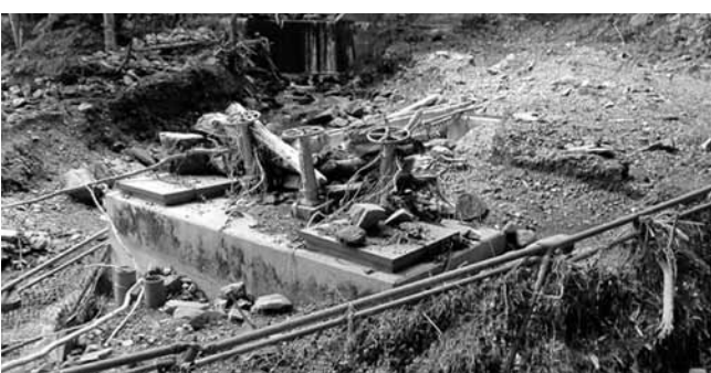
台風10号により被災した下川井飲料水供給施設
