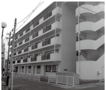
完成した災害公営住宅
