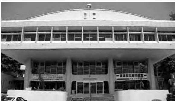
田老総合事務所庁舎
