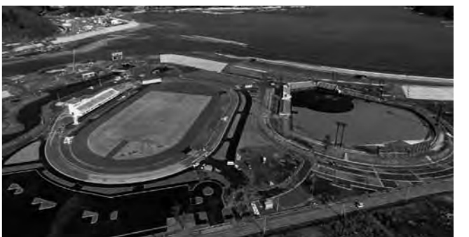
復旧工事中の宮古運動公園
