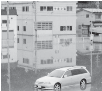
通行不能となった106号バイパス
