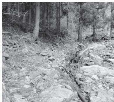
早期の復旧を待つ森林作業道
