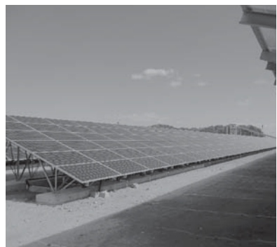
先行して進めている太陽光発電所
