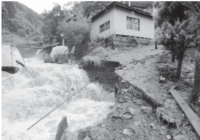
濁流で崩壊寸前の家屋
