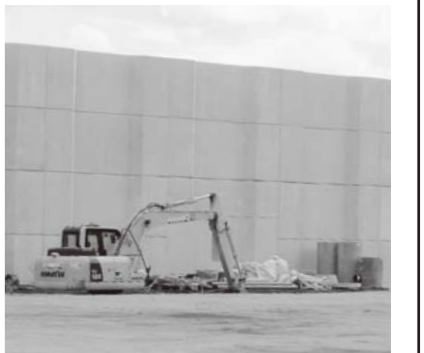
建設中の畷ヶ崎防潮堤
