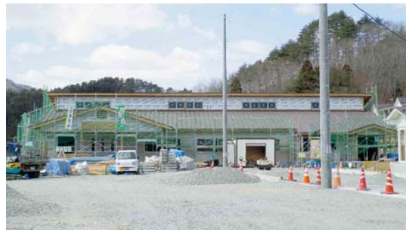
建設中の田老診療所
