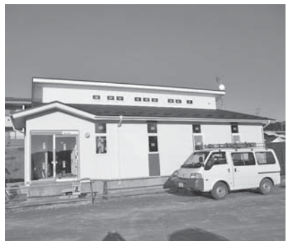
建設中の田老診療所
