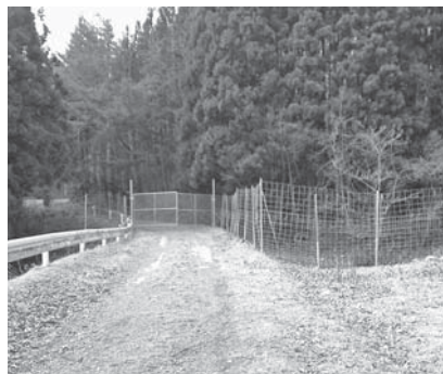
鳥獣防護柵（緩衝帯）
