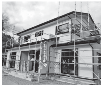
新築中の住宅
