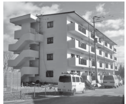
崎山地区の災害公営住宅
