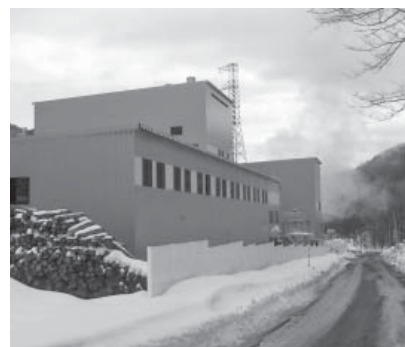
木質バイオマス発電施設(区界地区)
