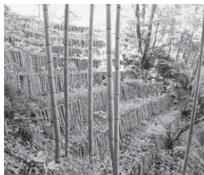
津波にも耐えたフォレストベンチ工法 (気仙沼市)
