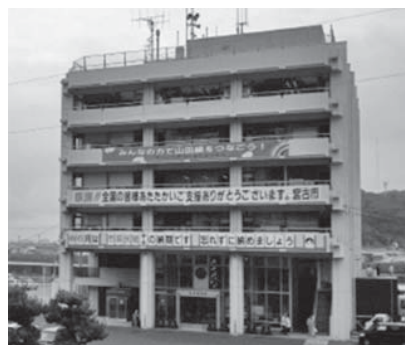
昭和47年築の市役所本庁舎
