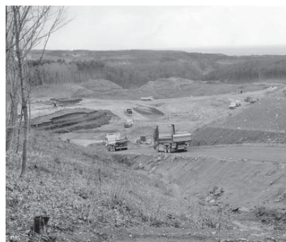
グリーンピア三陸みやこ敷地内の残土搬入の状況
