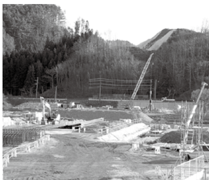
整備中の三陸沿岸道路
