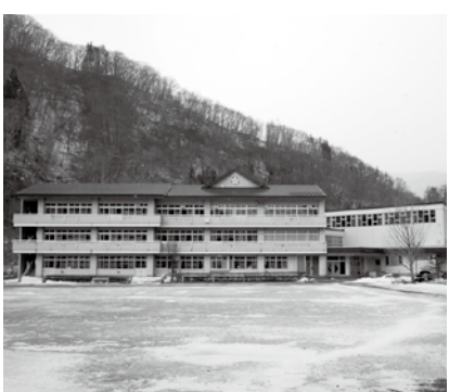
閉校する川井西小学校校舎
