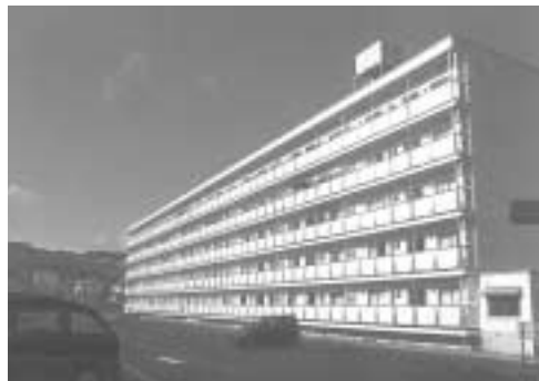
災害公営住宅に生まれかわる近内雇用促進住宅
