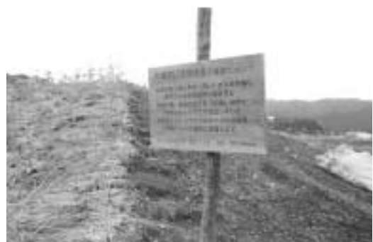
大槌町で実施されている震災がれきでの防潮堤
