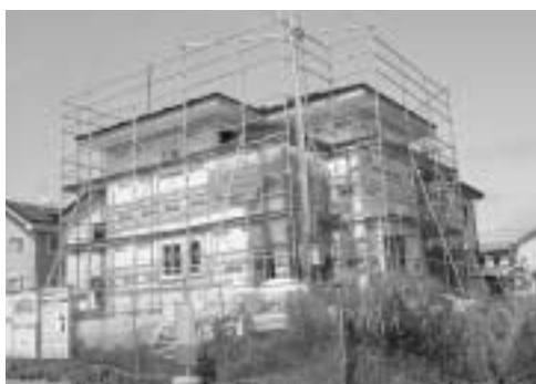
補助制度を活用して新築が進む
