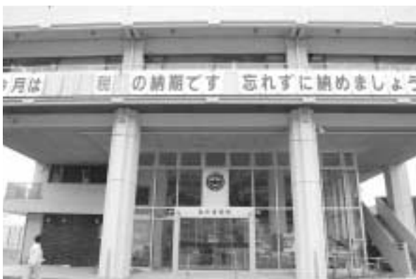
被災した一階部分の改修を終えた宮古市役所
