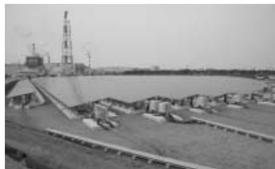
メガソーラー(八戸太陽光発電所)
