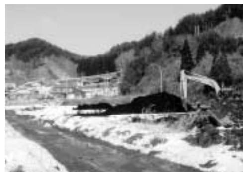
被災農地の復旧状況(松月地区)
