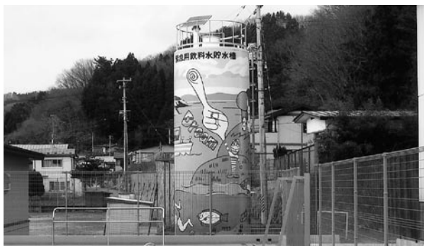
宮古小学校に設置されている緊急用飲料水貯水槽
