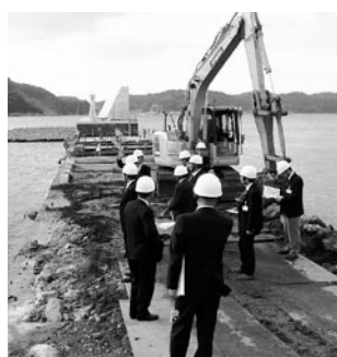
防潮堤の嵩上げ
