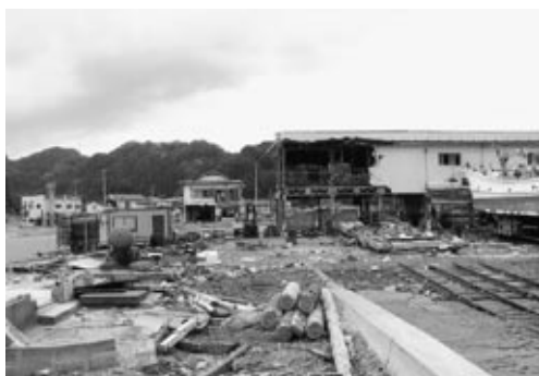
被災した鯵ヶ崎地区
