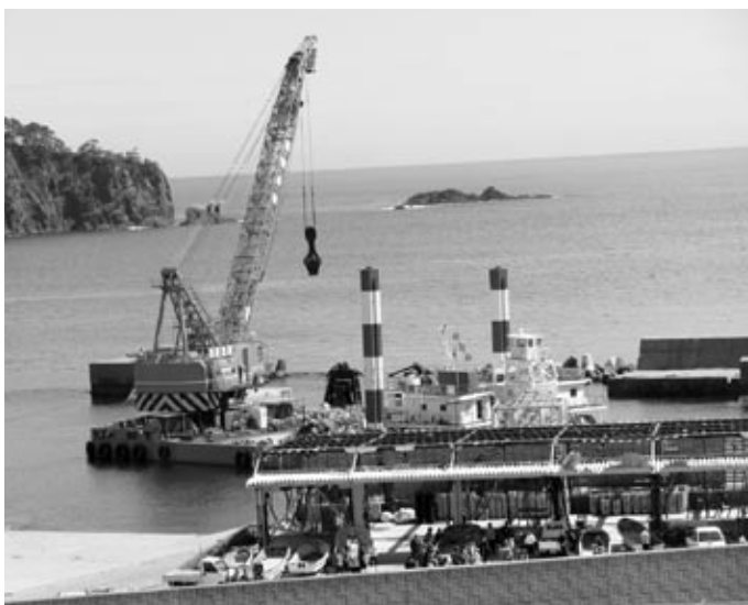
復旧工事(音部漁港)
