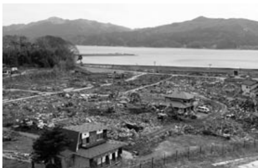
金浜地区の被害状況
