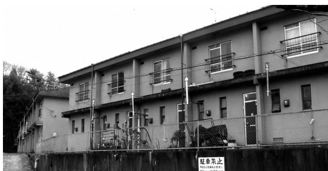
宮古市営住宅
