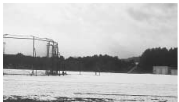
第3種公認陸上競技場改修工事予定地
