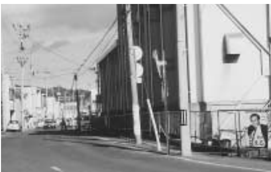
防潮堤整備予定地
