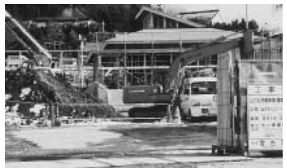
工事中の山口公民館
