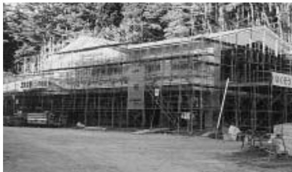
工事が進む浄土ヶ浜レストハウス
