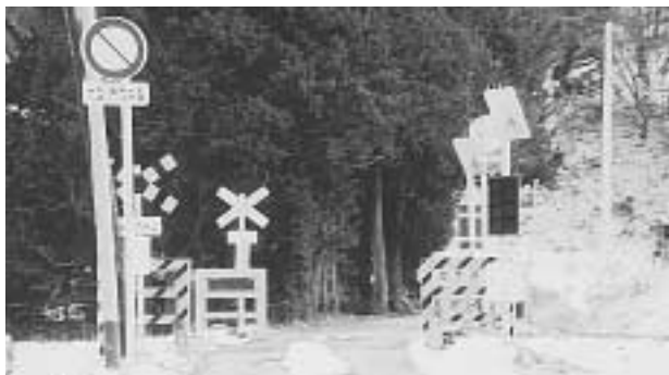
安全対策が急がれる盆景踏切
