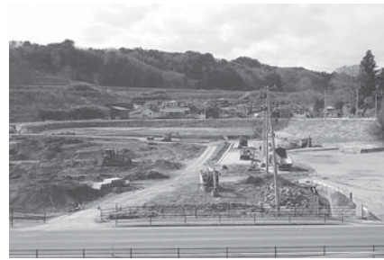
造成中の金浜地区産業用地
