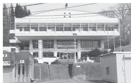
解体を待つ旧田老総合事務所庁舎
