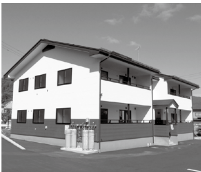
整備された高浜地区の災害公営住宅
