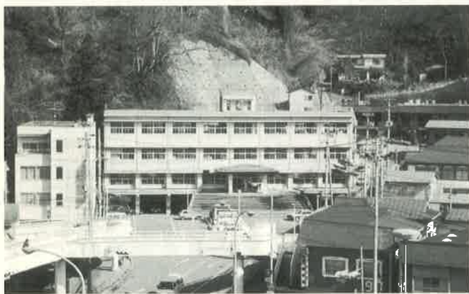
アスベスト使用の調査が必要な公共施設
