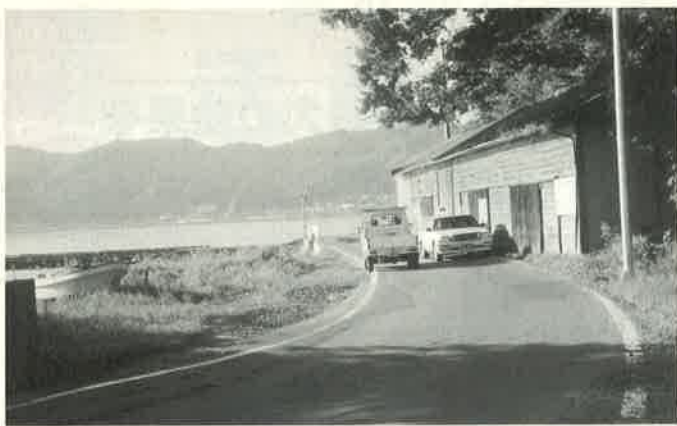
道巾が狭く早期の改良が必要な重茂街道
