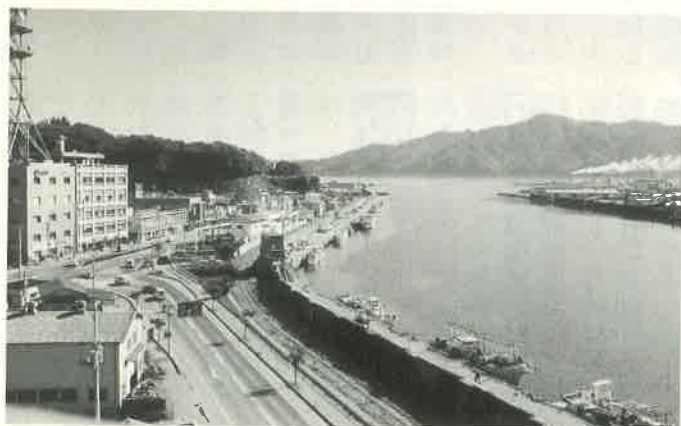
津波防災対策が望まれる関伊川河口部
