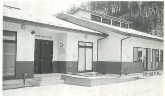
新たに設置された大野折壁交流センター
