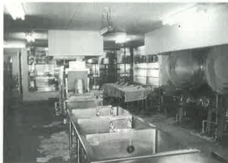
安全な調理器具に交換される調理室
