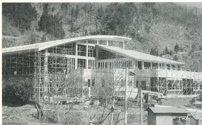
完成が待たれる亀岳小学校学校建築現場
