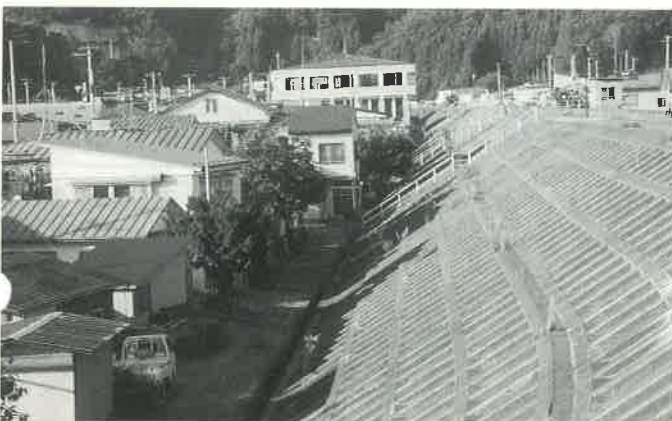
防潮堤に守られている田老地区
