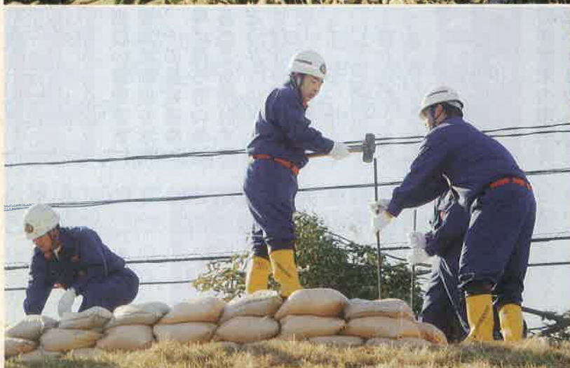
◀ 積土のう工法
