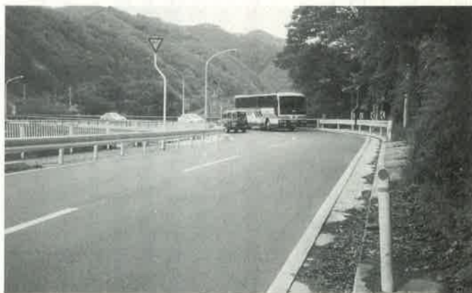
早期改良が切望される国道106号
