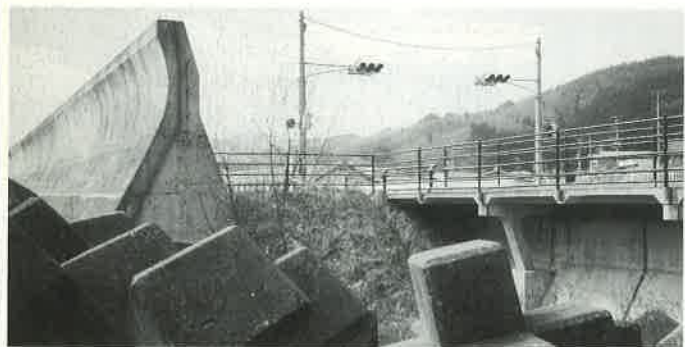
高浜北側防潮堤早期着工を
