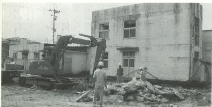
新築工事が始まった田老病院
