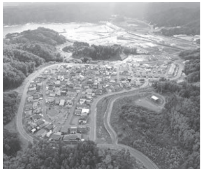
山を切り崩して造成した田老三王団地
