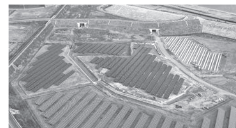
12月運用開始予定の田老地区の 夜間連系太陽光発電
