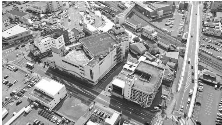
解体工事が行われる旧キャトル店舗
