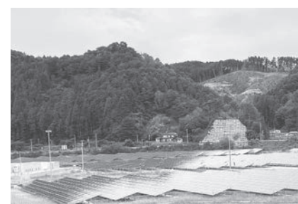
田老地区に設置された太陽光発電施設
