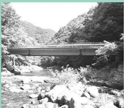
橋梁工事が行われる林道鬼米内線
