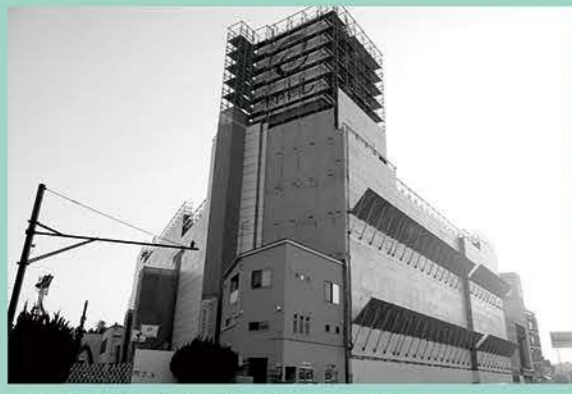
解体工事が行われている旧キャトル
