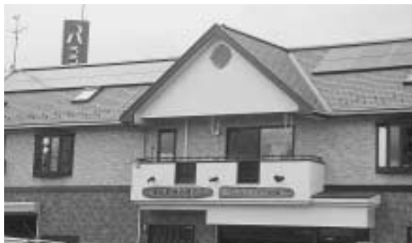
民間で導入している太陽光発電住宅
