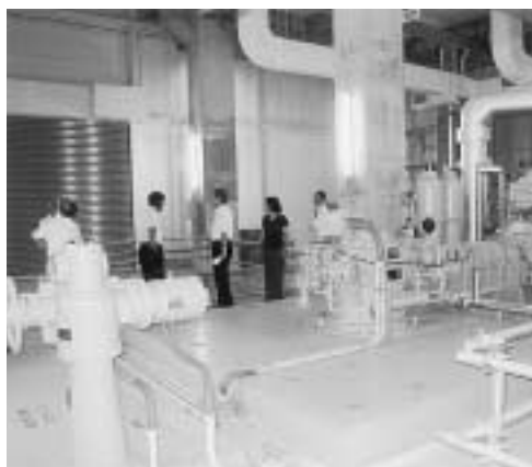
宮城県石巻市の浸水対策のポンプ場視察
