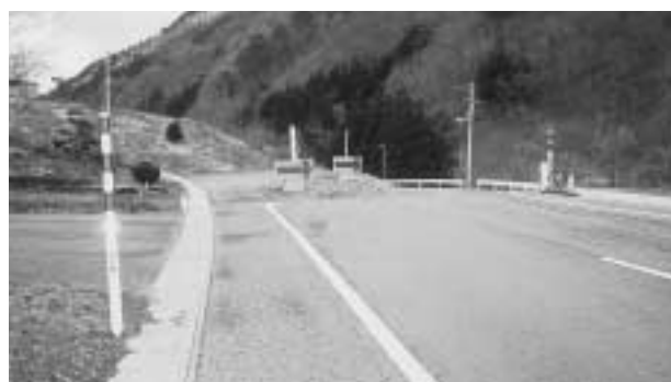
早期完成が望まれる国道340号線
