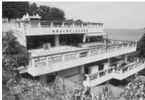
改築が望まれる浄土ヶ浜ターミナルビル
