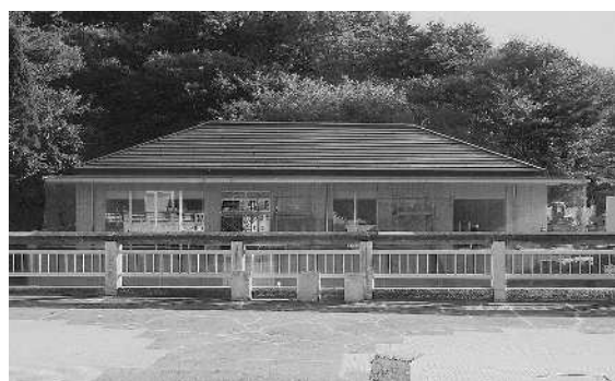
完成間近のビジターセンター
