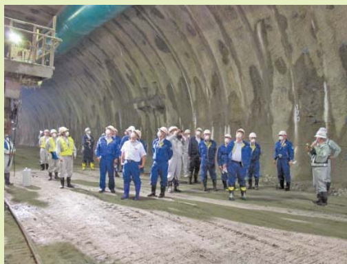
三陸沿岸道路の現地視察
