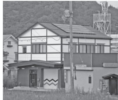
消防屯所に設置された太陽光発電設備
