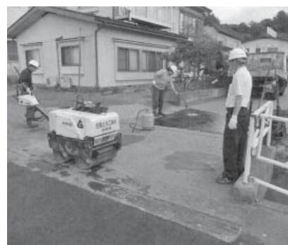
生活道路の工事状況
