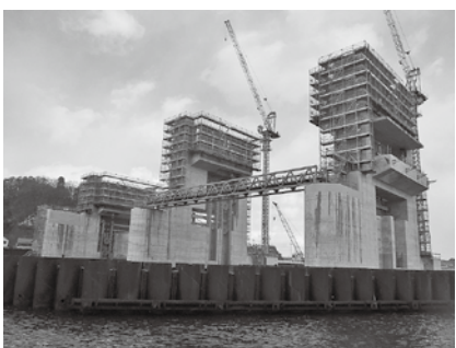
建設中の閉伊川水門
