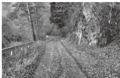
舗装道路の整備が待たれる市道摂待川線
