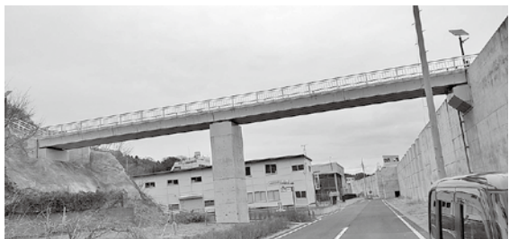
宮古魚市場から漁協ビル駐車場 高台へ避難する避難橋
