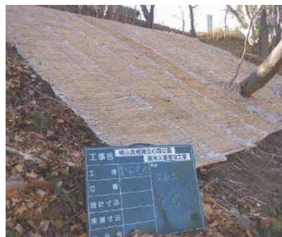
国指定 崎山貝塚災害復旧工事 (2017年・2021年)
