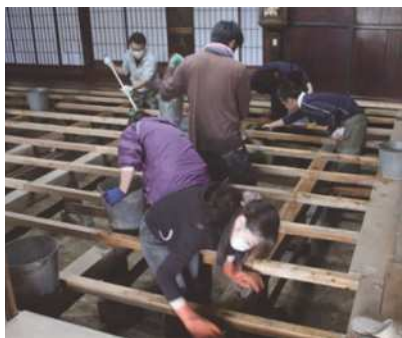
国登録 盛合家住宅主屋 津波被害による床洗い作業
