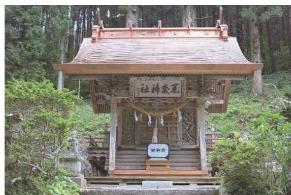
市指定 黒森神社本殿修復（屋根改修工事）
