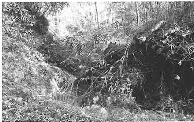
崎山貝塚復旧工事(Bブロック)
