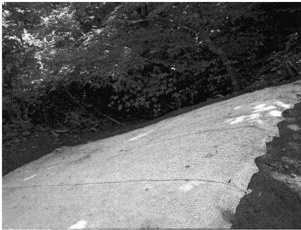
法面復旧状況
