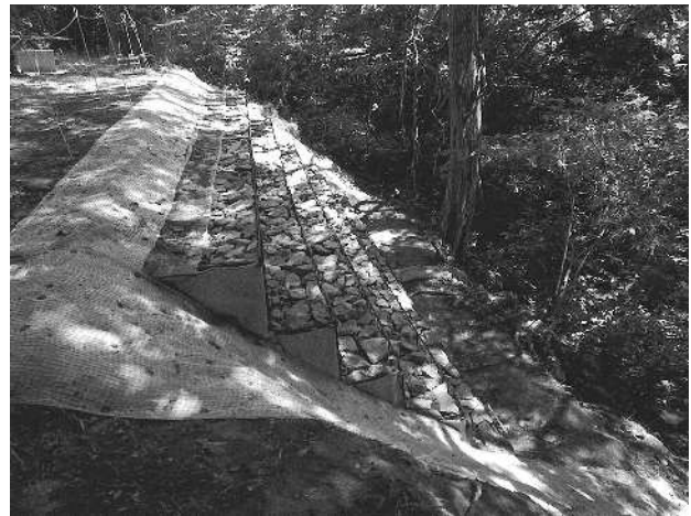
かご枠設置状況
