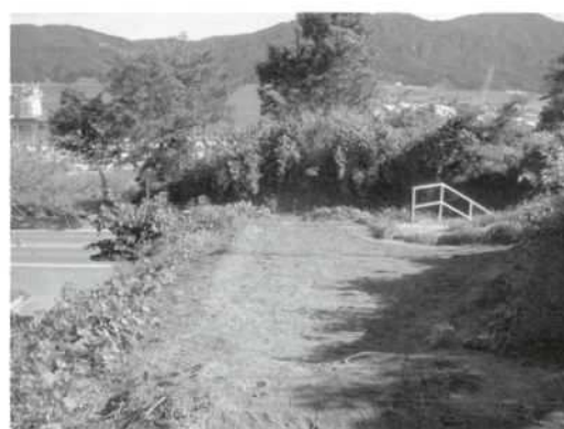
67. 調査区 埋め戻し状況(西→)
