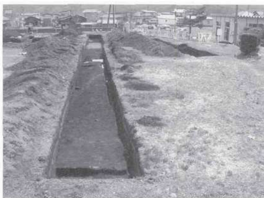
11. A区 試掘トレンチ掘り下げ状況 (西→)
