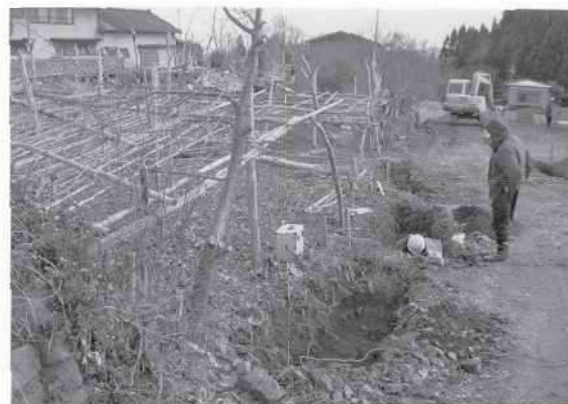
73. 工事立会（側溝工事）（北→）
