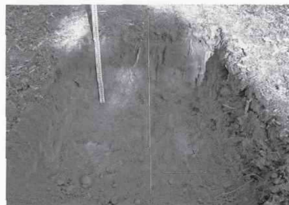
75. 工事立会（側溝工事）（南→）
