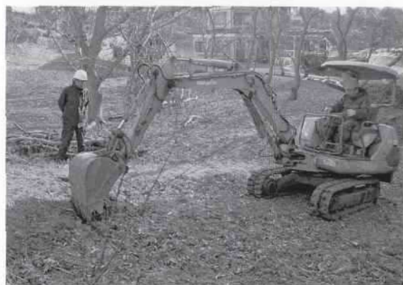
74. 工事立会（側溝工事）（西→）
