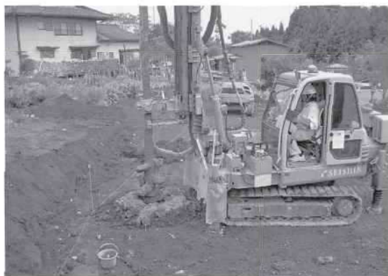
118. 工事立会（柱状改良）（北→）
