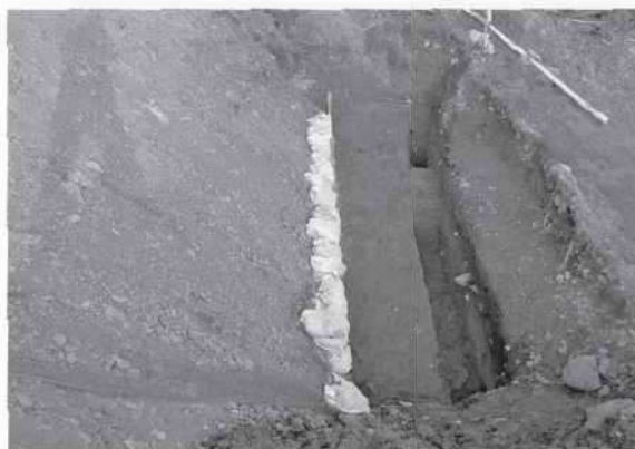
70. 4次調査 調査状況（西→）
