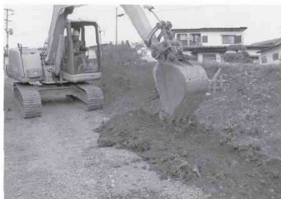
72. 工事立会（側溝工事）（南→）
