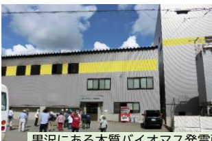
黒沢にある木質バイオマス発電所
